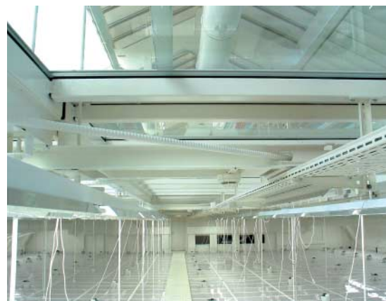
Bild 2: Blick in die Zwischendecke des grossen Pfistersaales mit Beleuchtungs-, Beschattungs- und Lüftungsanlagen. (Foto: BUS-House)
